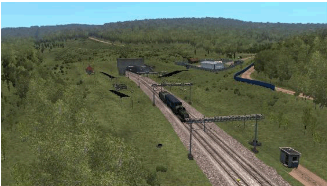
Рис. 12. Северо-западный въезд в тоннель (1)
